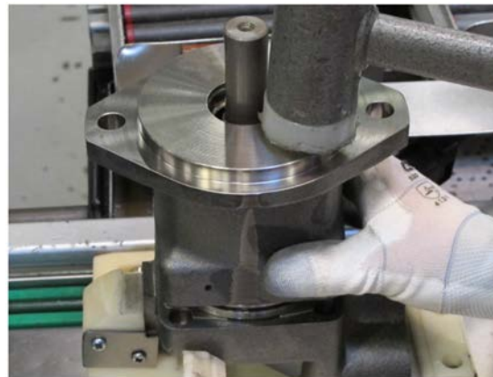
17. Осторожным постукиванием осадить часть корпуса гидромашины.
